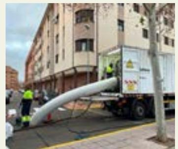
La rehabilitación ha consistido en la instalación de una manga CIPP (manga continua más resina), mediante un sistema de aire presión y curación, restableciendo la capacidad estructural e hidráulica, eliminando filtraciones para dotar al colector de una nueva vida útil, superior a los 50 años.
